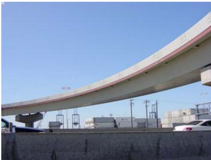
Σχ. 2.5.1-7 Καμπύλη συνεχής δοκός κιβωτιοειδούς διατομής
