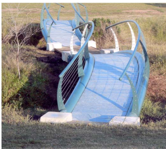
Σχ. 2.5.1-2 Οριζοντίως καμπυλομένες μεταλλικές δοκοί (άνω) και καμπύλες δοκοί στον
