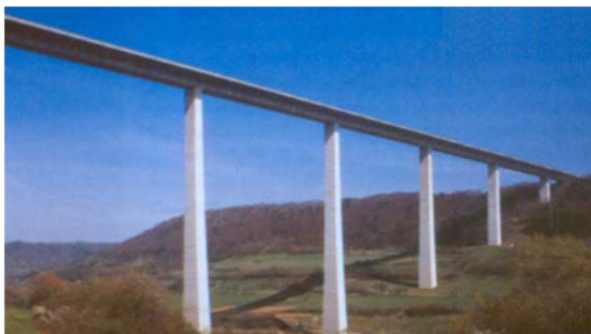
Σχ. 2.5.1-6 Γέφυρα οπλισμένου σκυροδέματος με κιβωτιοειδή διατομή: Συνεχής δοκός επί πολλαπλών στηρίξεων (βάθρων)
