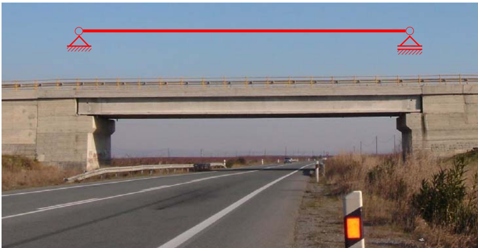
Σχ. 2.5.1-1 Απλές (αμφιέριστες) δοκοί: Άνω: Stonehedge, νεολιθικό μεγαλιθικό μνημείο (2500-2000 π.Χ.) στο Amesbury της Αγγλίας. Μέση: Γέφυρα από κορμούς δένδρων. Κάτω: Σύγχρονη αμφιέριστη οδογέφυρα οπλισμένου σκυροδέματος με προένταση.
