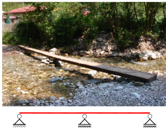
Σχ. 2.5.1-4 Συνεχής δοκός δύο ανοιγμάτων από επεξεργασμένο κορμό δένδρου
