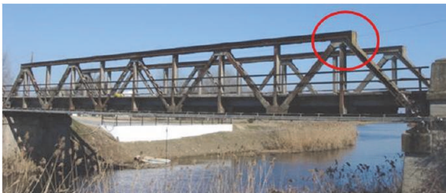
(α) Μεταλλική σιδηροδρομική γέφυρα με δύο κύριες δικτυωτές δοκούς
