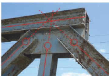
(β) Πραγματικός κόμβος μεταλλικού δικτυώματος και η προσομοίωσή του ως ιδανικής άρθρωσης
