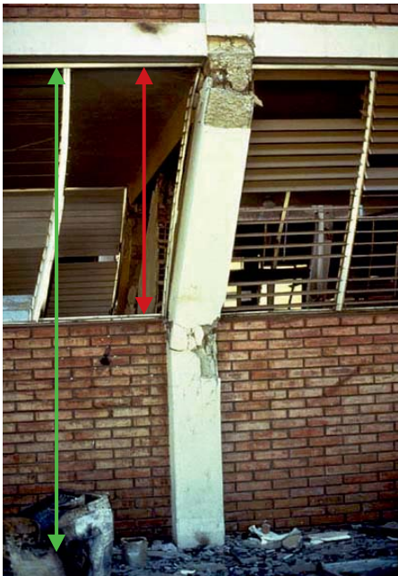
Σχ. 2.1.2-2 Επικίνδυνες διαμορφώσεις: Κοντά υποστυλώματα (άνω και κάτω αριστερά: λόγω προσθήκης τοιχοποιίας στον φ/ο, κάτω δεξιά: βάσει αρχικού σχεδιασμού)
