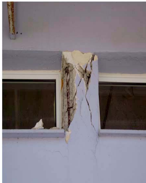
Σχ. 2.1.2-2 Επικίνδυνες διαμορφώσεις: Κοντά υποστυλώματα (άνω και κάτω αριστερά: λόγω προσθήκης τοιχοποιίας στον φ/ο, κάτω δεξιά: βάσει αρχικού σχεδιασμού)
